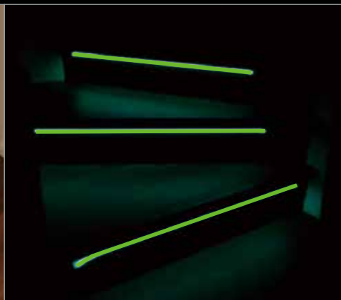
(階段設置 施工事例)
